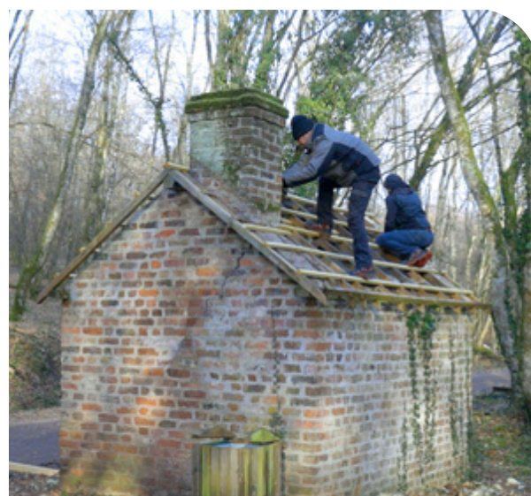
CABANE PETIT JEAN En janvier des travaux de rénovation ont été réalisés par nos agents techniques. Toiture, nouvelle porte et nettoyage de briques au programme.
