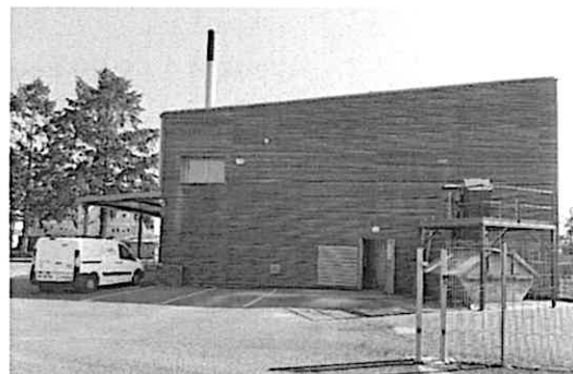
Vue extérieure de la chaufferie biomasse
